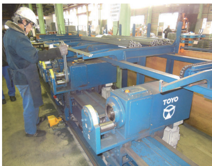
写真 4 曲げ加工状況
