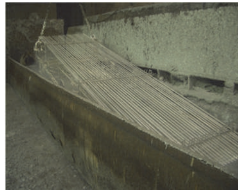
図 8.1 溶融亜鉛めっき浴からの鉄筋の引上げ
