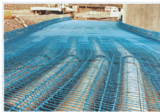
図 8.10 エポキシ樹脂塗装鉄筋の施工例
